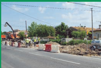
Le partenariat CUB/Parempuyre : les travaux de la rue de Macau
