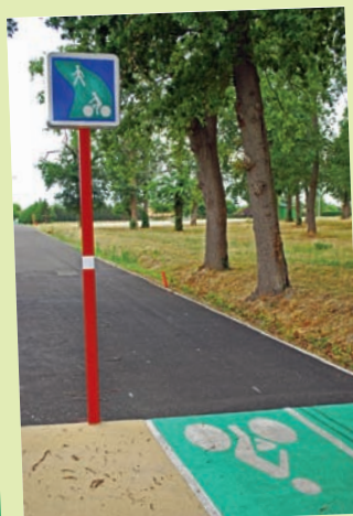
Voie verte sur l'avenue Château Pichon
