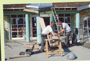
Réfection de la façade du bâtiment de la mairie
