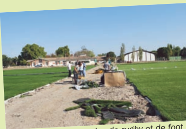
Réalisation des terrains de rugby et de foot en 2009 à la plaine des sports
